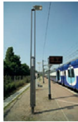
Mâts basculants avec embout en top Ø 60 x 100 mm
