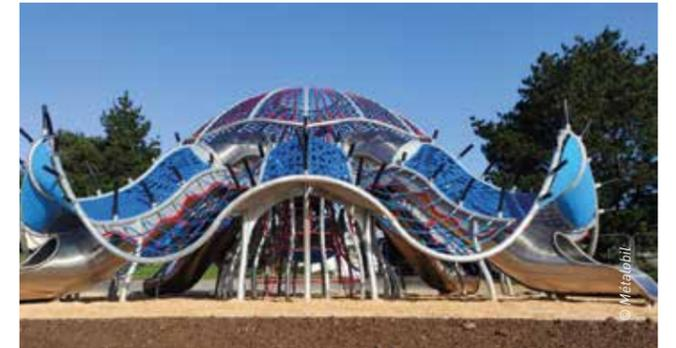
ble défi technique de fabrication, des filets en polypropylène renforcé avec des câbles en acier, des membranes en PEHD, des toboggans en inox, des cils en caoutchouc... La structure mesure 9 mètres de diamètre sur 4 mètres de haut. »
