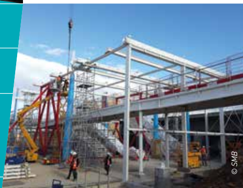
Montage de l'ombrière. En bleu, les poteaux en chêne lamellé-collé protégés pour le chantier.
