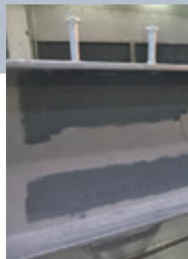
Dans tous les cas, l'épaisseur de revêtement sur les zones reconditionnées doit être égale à 100 µm sauf accord contraire et explicite du client, en particulier en cas de revêtements supplémentaires de finition. Le revêtement de reconditionnement doit avoir les facultés sacrificielles nécessaires vis-à-vis de l'acier.
