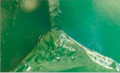
**\_ Peinture sur grattons et tôle corrodée**
