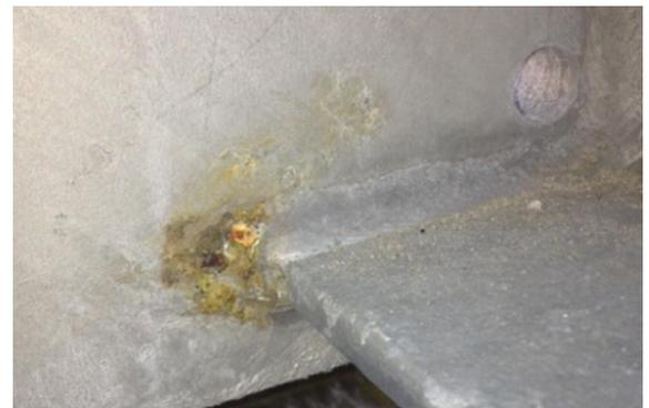
**Les soudures non continues ou les fentes** de largeur inférieure à 3 mm créent un phénomène de ressuage.
