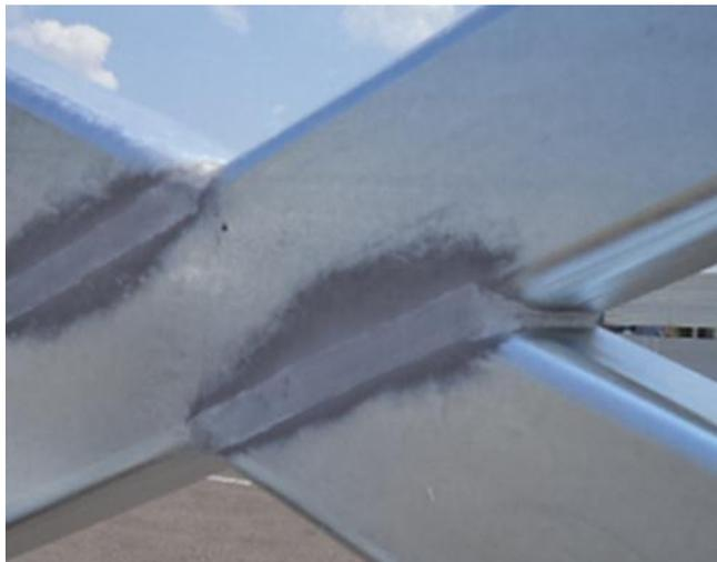
Une soudure sur aciers génère une température d'environ 3000°C ponctuellement en soudure à l'arc et 25000°C pour le plasma ce qui modifie les caractéristiques sidérurgiques de la zone soudée et celle en périphérie.
